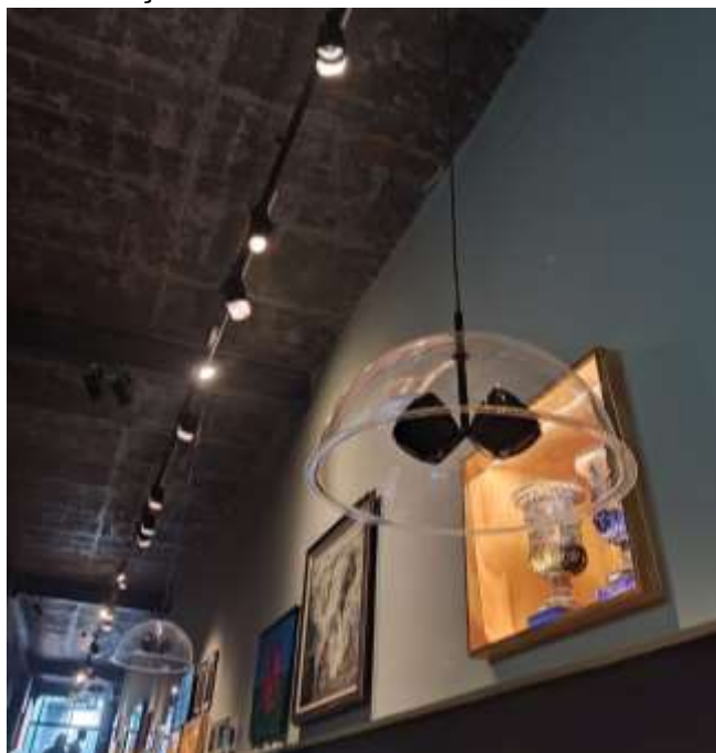
FIGURA 13 – COLOCAÇÃO DAS CAIXAS DE SOM ACOPLADAS EM CÚPULAS.
