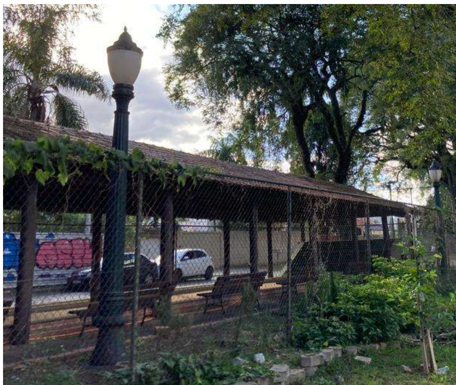
FIGURA 12 – VISTA DE UM DOS POSTES DE ILUMINAÇÃO DISPONÍVEIS NO LOCAL
