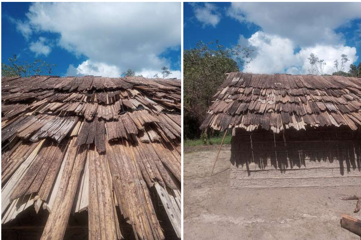
Figuras 5 e 6 - Telhado de Bambu
