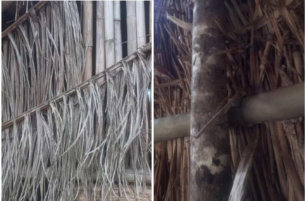
Figura 4 e 5 - vedação e capim e estrutura do telhado
