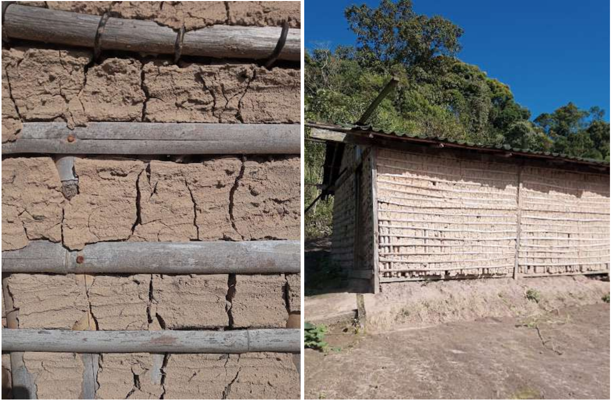
Figura 3 e 4 - Parede taipa de bambu finalizada
