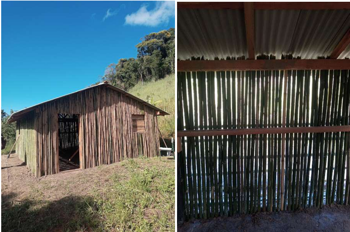
Figuras 2 e 3 - Paredes de bambu
