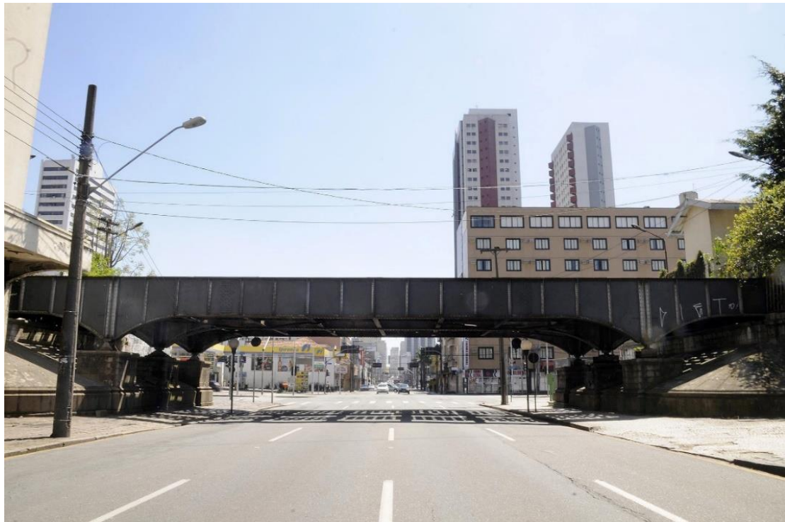
Figura 15: Ponte João Negrão
