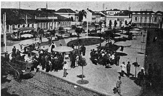
Figura 5: Mercado-Feira, já em funcionamento no ano de 1917.
