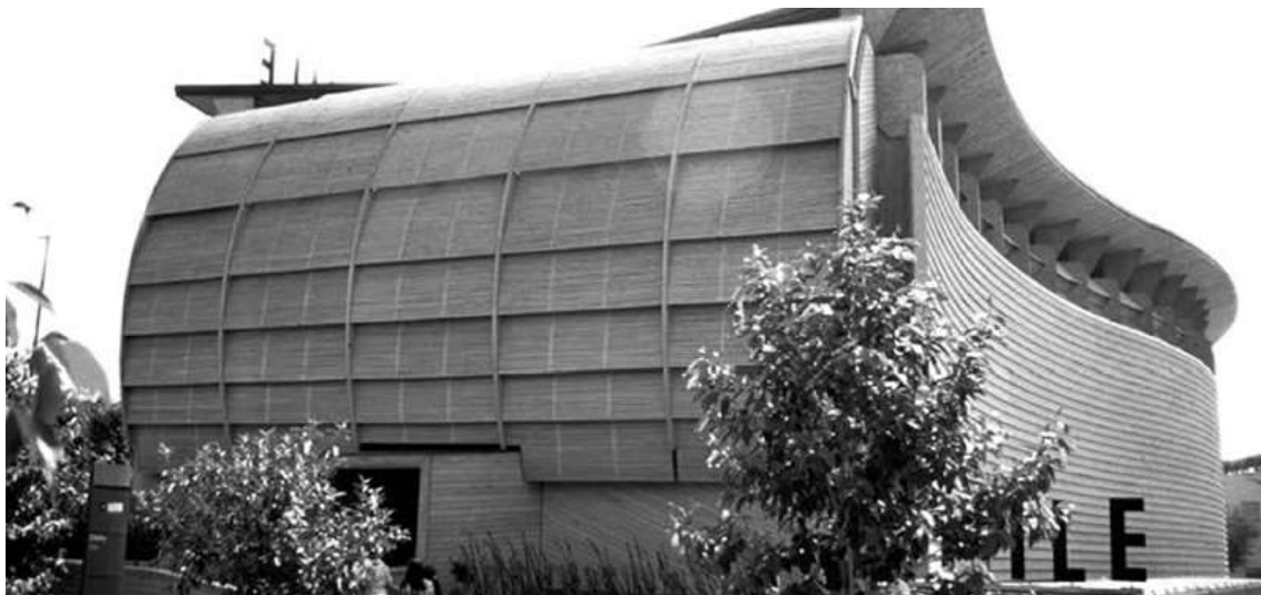
FIGURA 1 - PAVILHÃO DO CHILE NA EXPO DE SEVILHA
