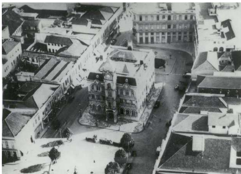
FIGURA 7- PRAÇA MUNICIPAL APÓS REMODELAÇÃO
