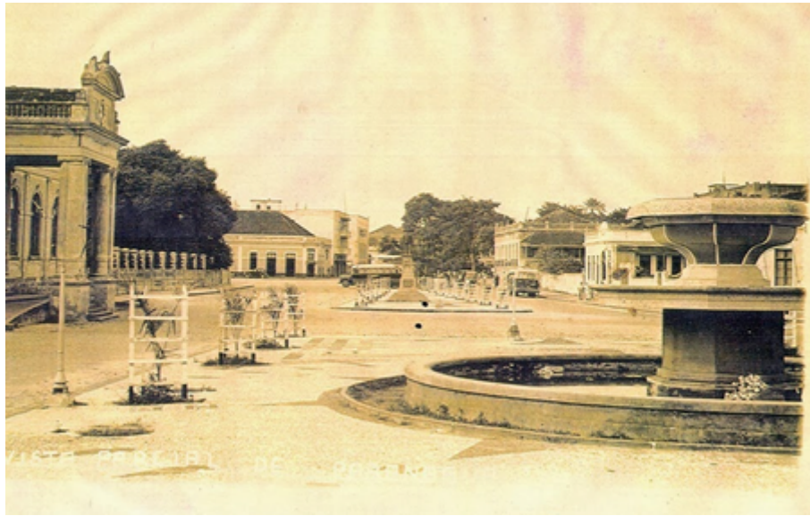
Figura 19 - Avenida Arthur de Abreu
