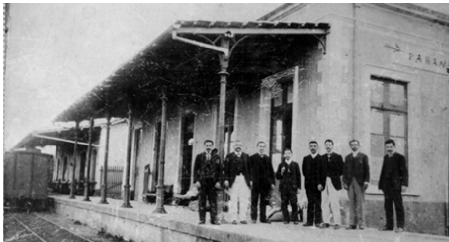
Figura 3 - Estação original plataforma de embarque
