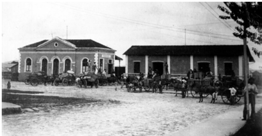
Figura 1- Estação original fachada principal e depósito
