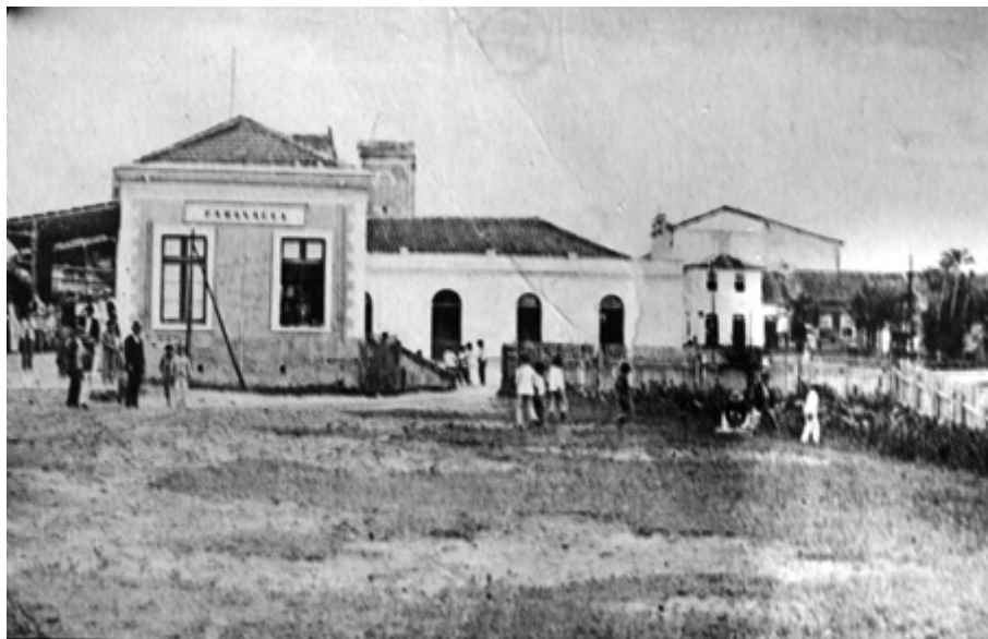
Figura 7 - Estação original fachada lateral
