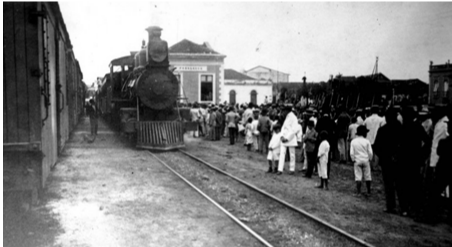
Figura 8 - Grande número de pessoas no lado externo da Estação
