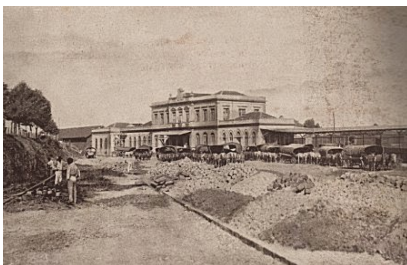
Figura 6 - Construção da Praça João Pessoa
