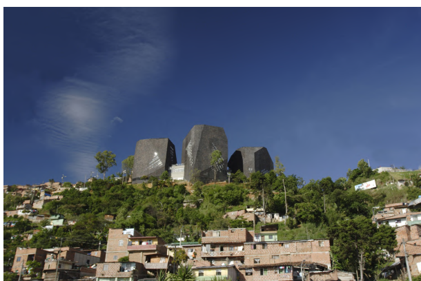
Figura 07 - Vista do Parque Biblioteca España
