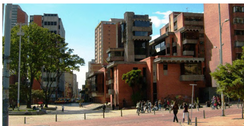
Figura 02 - Edifício ICFES, Bogotá, Colômbia, projetado pelo arquiteto Aníbal Moreno Gómez
