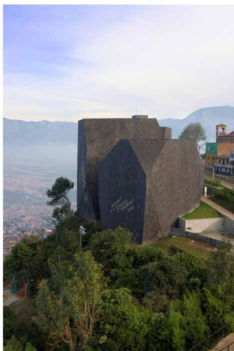
Figura 04 - Vista do Parque Biblioteca España
