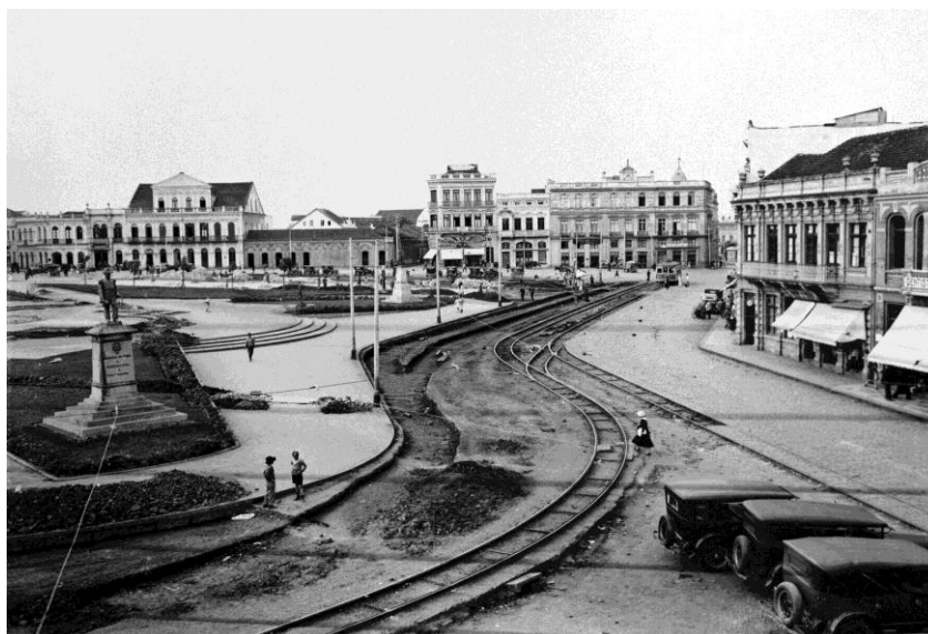
FIGURA 2 - OBRAS DE REMODELAÇÃO NA PRAÇA TIRADENTES (1934)
