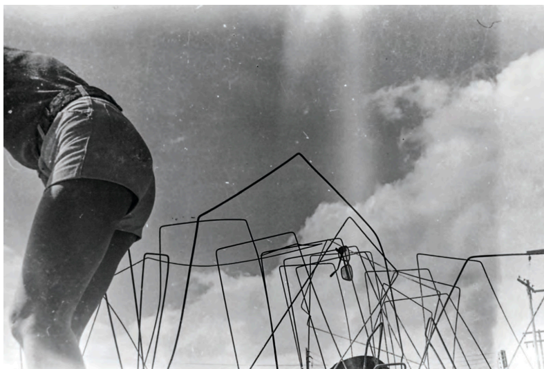
Sábado de Criação, Canteiro de obras da Rodoferroviária, 1971.
