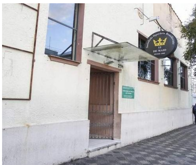
FIGURA 8 - FACHADA ATUAL DA SEDE DO CLUBE TREZE DE MAIO EM CURITIBA
