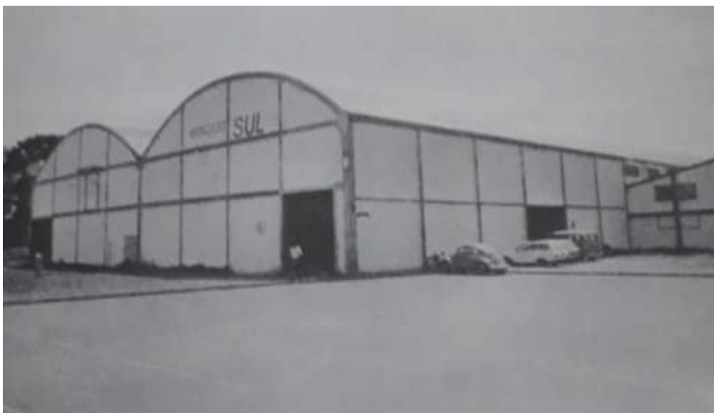
FIGURA 9 - Vista lateral dos barracões do mercado sul (MERCASUL)
