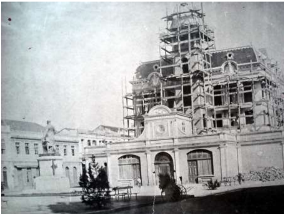
Figura 4: A imagem mostra a construção do Paço Municipal, em 1915, no local onde funcionava o mercado. As paredes externas da edificação serviram como tapume para a obra.
