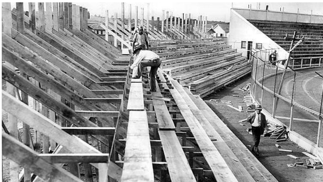
Figura 8 - Construção de arquibancadas de madeira para a Copa do Mundo.
