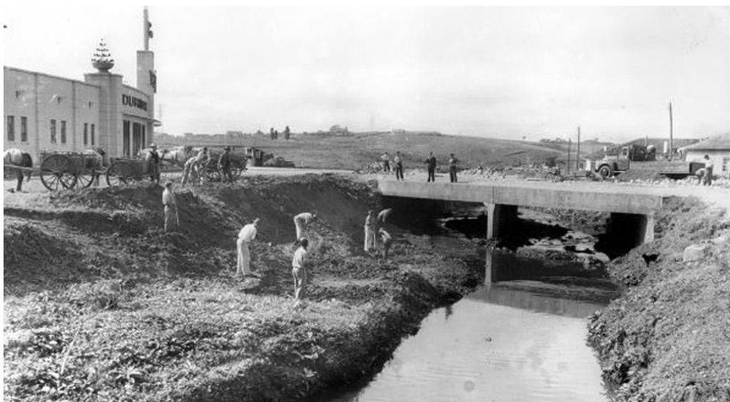
Figura 9 - Limpeza do Rio Belém para a Copa, em junho de 1950.
