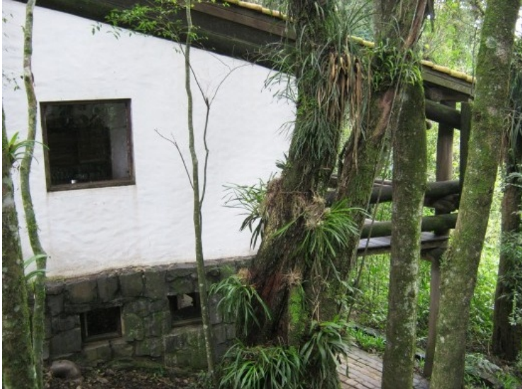
Detalhe das pedras utilizadas para isolar o fechamento da casa [Acervo dos autores]
