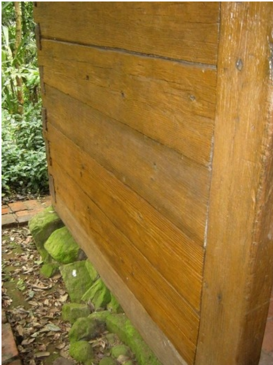
Detalhe das pedras utilizadas para isolar o fechamento da casa [Acervo dos autores]
